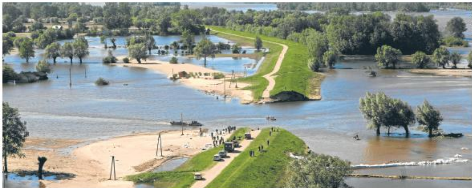
4 czerwca 2010 r., Świnoujście. Żołnierze i strażacy budują tzw. opaskę w mieście, gdzie Wisła przetrwała wał. Opaska ma położyć w zasypaniu wyrywy w wałach oraz chronić pobliskie miejscowości przed ponownym zalaniem
