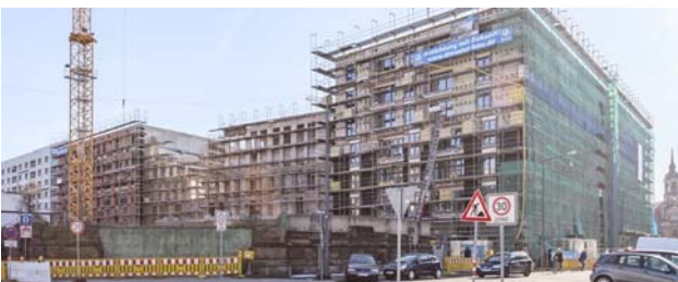
Am Dresdner Postplatz wird kräftig gebaut. Fast 1.000 Wohnungen sollen dort entstehen. Foto: baywobau
